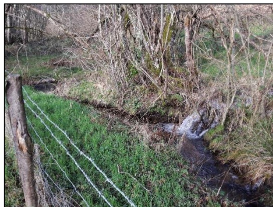
Photo 8 : Vue sur l'exutoire des eaux traitées
